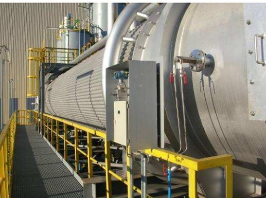
**Abbildung 2:** deltaflow mit Luftspüleinrichtung LSP (Verbindung durch Impulsleitungen)
