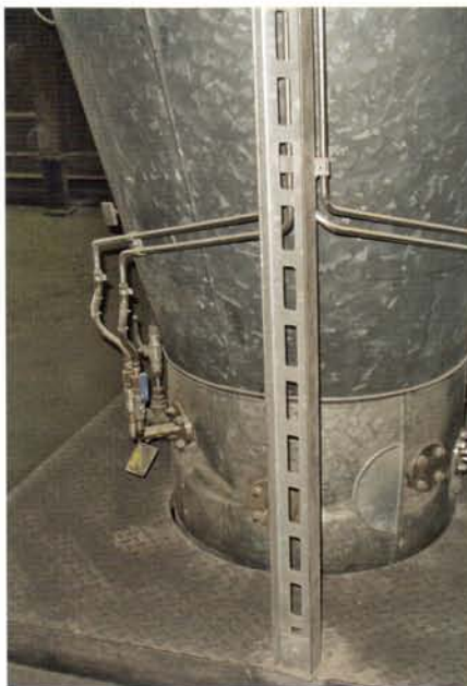
Über-Kreuz-Montage der Staudrucksonden.
